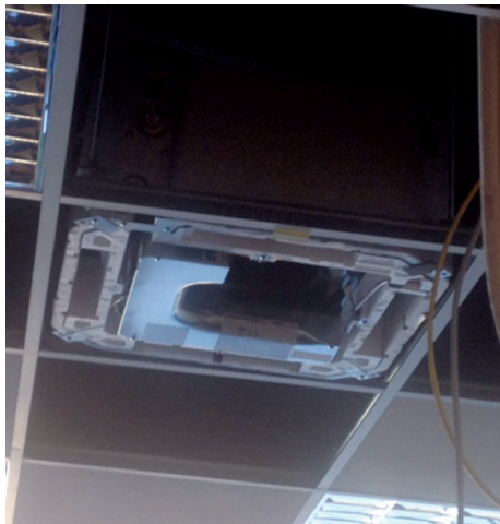
Montage des Kassettengerätes
