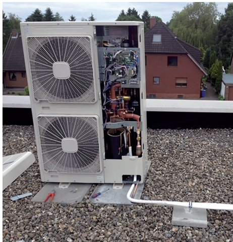
Dachinstallation der Außeneinheit
