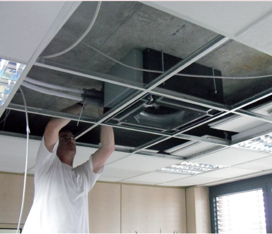
Einbau einer RAI 25 Hitachi Inneneinheit in die Euro-Rasterdecke eines Büroraums
