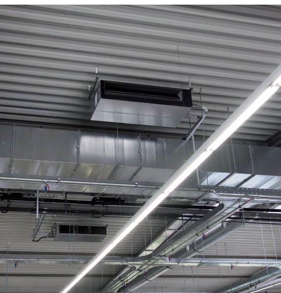
Luftverteilung im Produktionsbereich über frei hängende Zwischendeckengeräte
