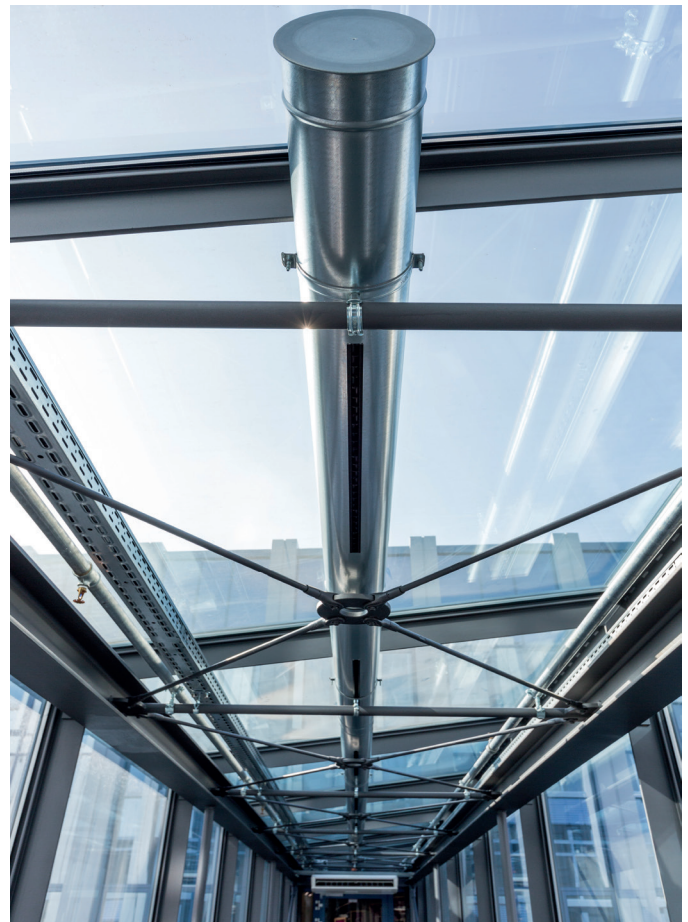
Großzügige Fensterflächen bieten viel Licht, gleichzeitig ist eine Klimatisierung unumgänglich. Hier gelöst mit einer RLT-Anlage in Kombination mit einem VRF-System.
