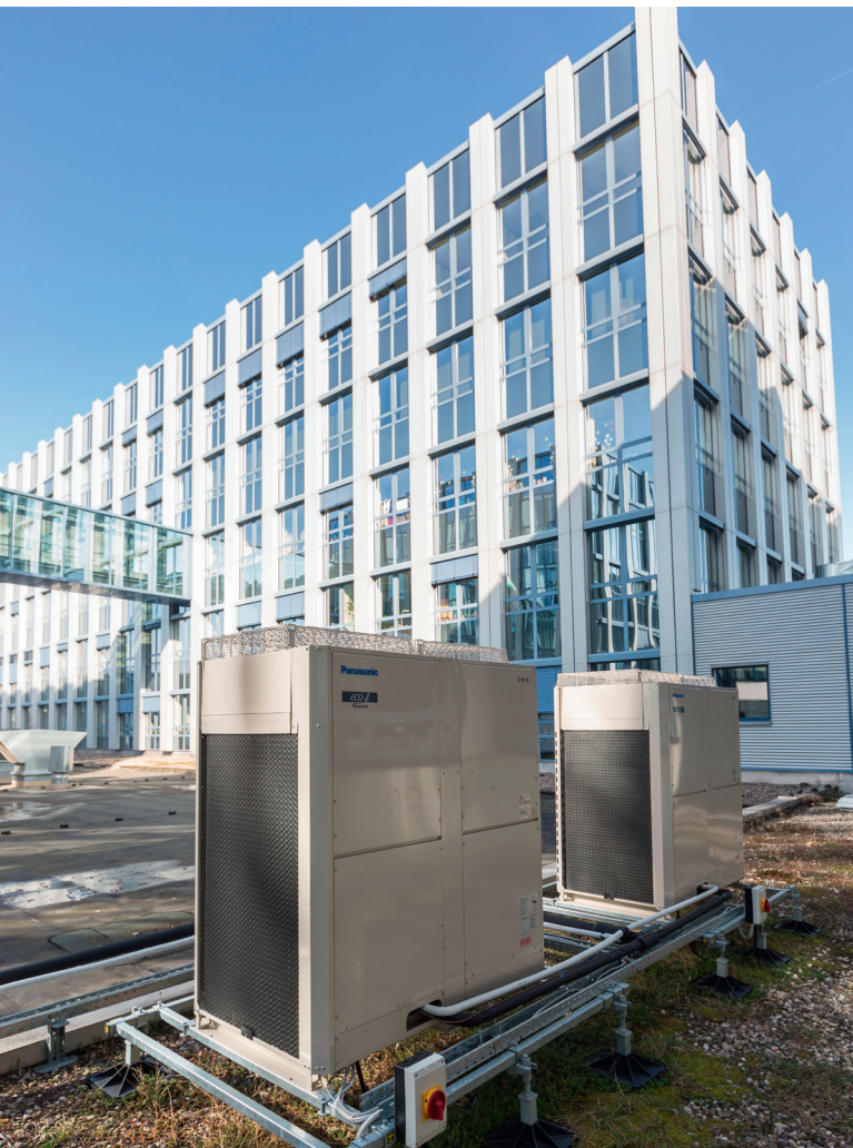
Großzügige Fensterflächen bieten viel Licht, gleichzeitig ist eine Klimatisierung unumgänglich. Hier gelöst mit einer RLT-Anlage in Kombination mit einem VRF-System.
