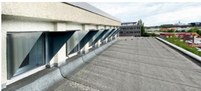
Auf dem Gebäudedach montierte Luftansaug- und -ausblasöffnungen
